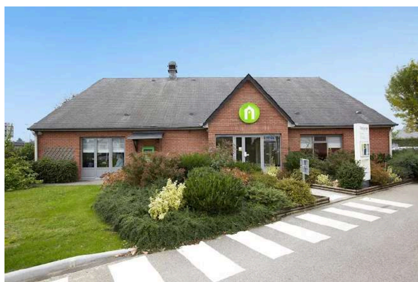
Campanile Rouen Est - Franqueville St Pierre
